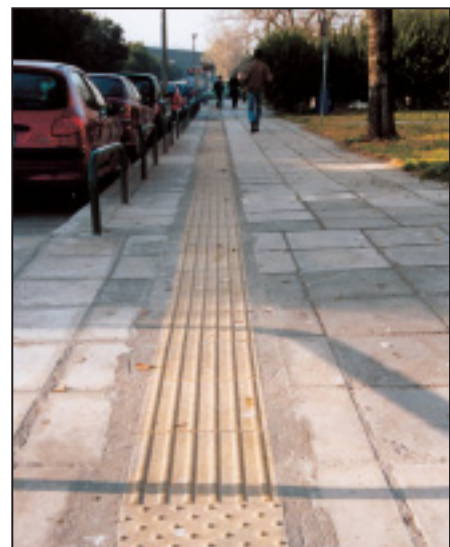
Έχουν τοποθετηθεί ειδικές πλάκες-οδηγοί στα πεζοδρόμια για τη διευκόλυνση της κίνησης των τυφλών.
