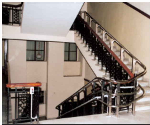
Για τους φοιτητές με κινητικά προβλήματα τοποθετήθηκαν πέρα από τις υπάρχουσες ράμπες και ειδικοί επίτοιχοι διάδρομοι.
