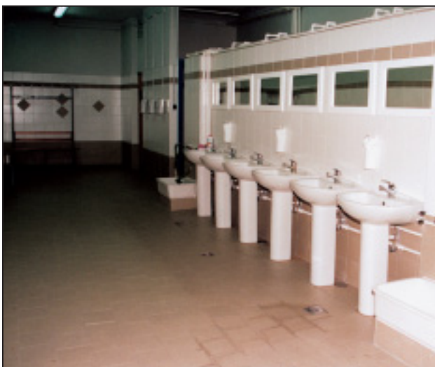
Ανακαινίστηκαν αποδυτήρια φοιτητών και φοιτητριών στο Πανεπιστημιακό Γυμναστήριο.
