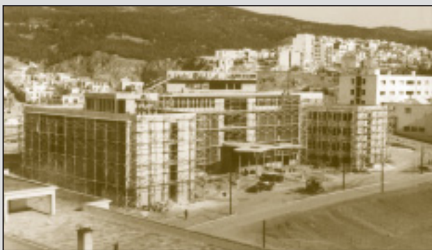
Το κτίριο της Φυσικομαθηματικής Σχολής θεμελιώθηκε το 1939. Οι εργασίες κατασκευής του όμως άρχισαν το 1957 (φωτ. αρχείο Κ. Τριαρίδη).
