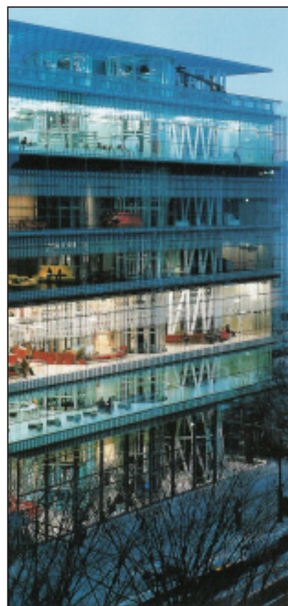
Mediatheque, Ιαπωνία. Αρχιτέκτων: Toyo Ito. Μεταλλικές κολώνες περικλείουν ανελκυστήρες και αεραγωγούς και δρουν ως φωταγωγοί.
