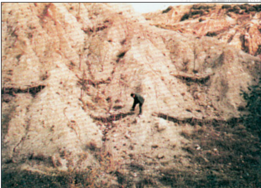
Προσπάθεια συγκράτησης με πρόχειρα φράγματα-κλαδοπλέγματα.
